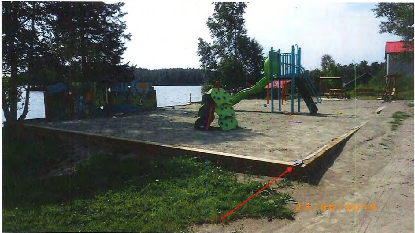
Photo 8 : Présence d'une membrane géotextile.
